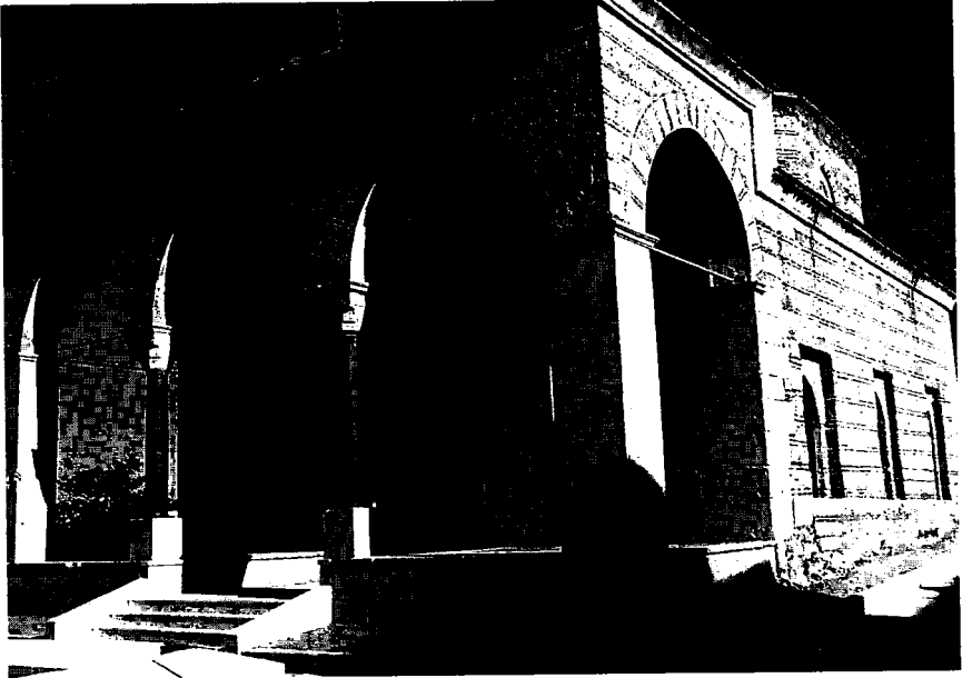
Resim 6: Yıldırım Bayazıt Türbesi, batı (ön) cephesi
