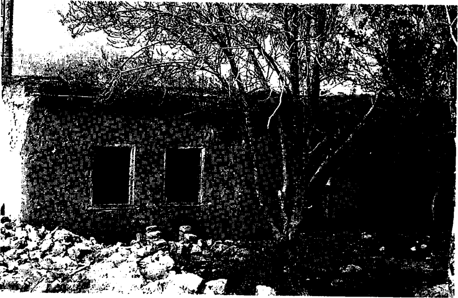
Resim 2: Karaman'da 28 no lu evin güneydoğu cephesi
