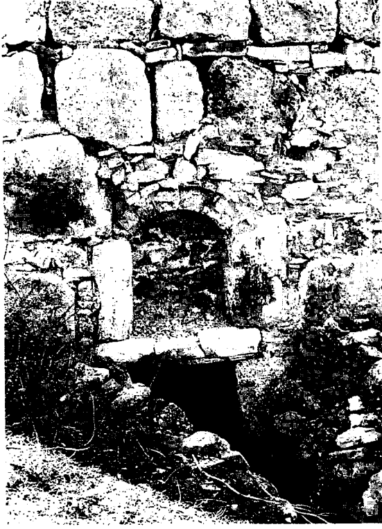
Resim 17: Şeyh Yahşi Köyü Türbesi, kapı
