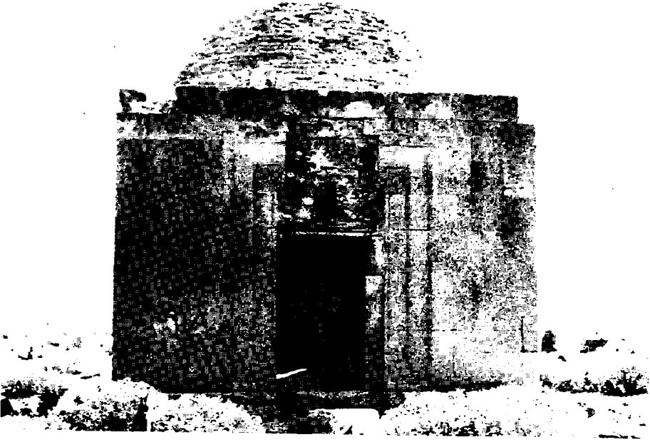
Resim 27: Yapılcın Köyü Türbesi, kuzey cephesi
