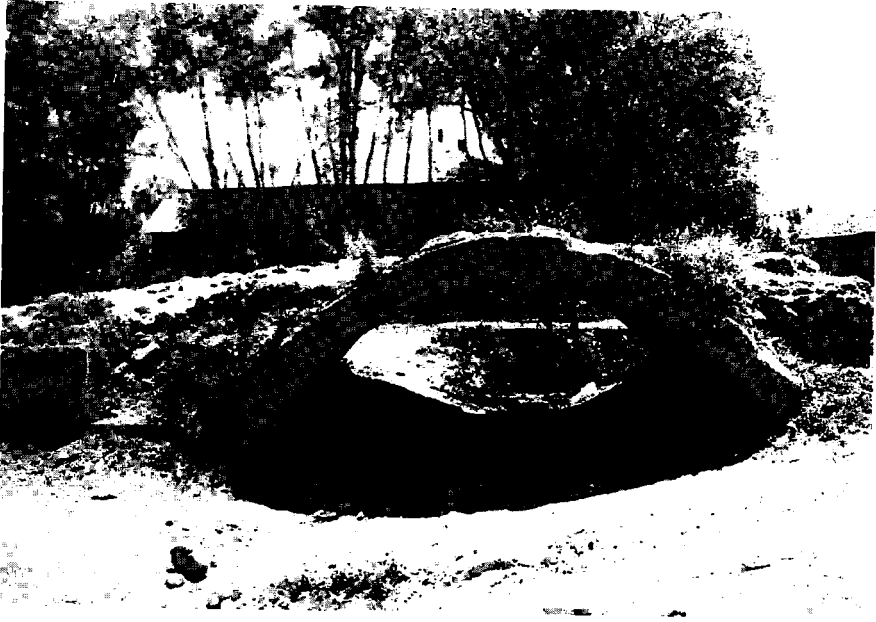
Resim 23: Altıntaş Köyü'ndeki köprü
