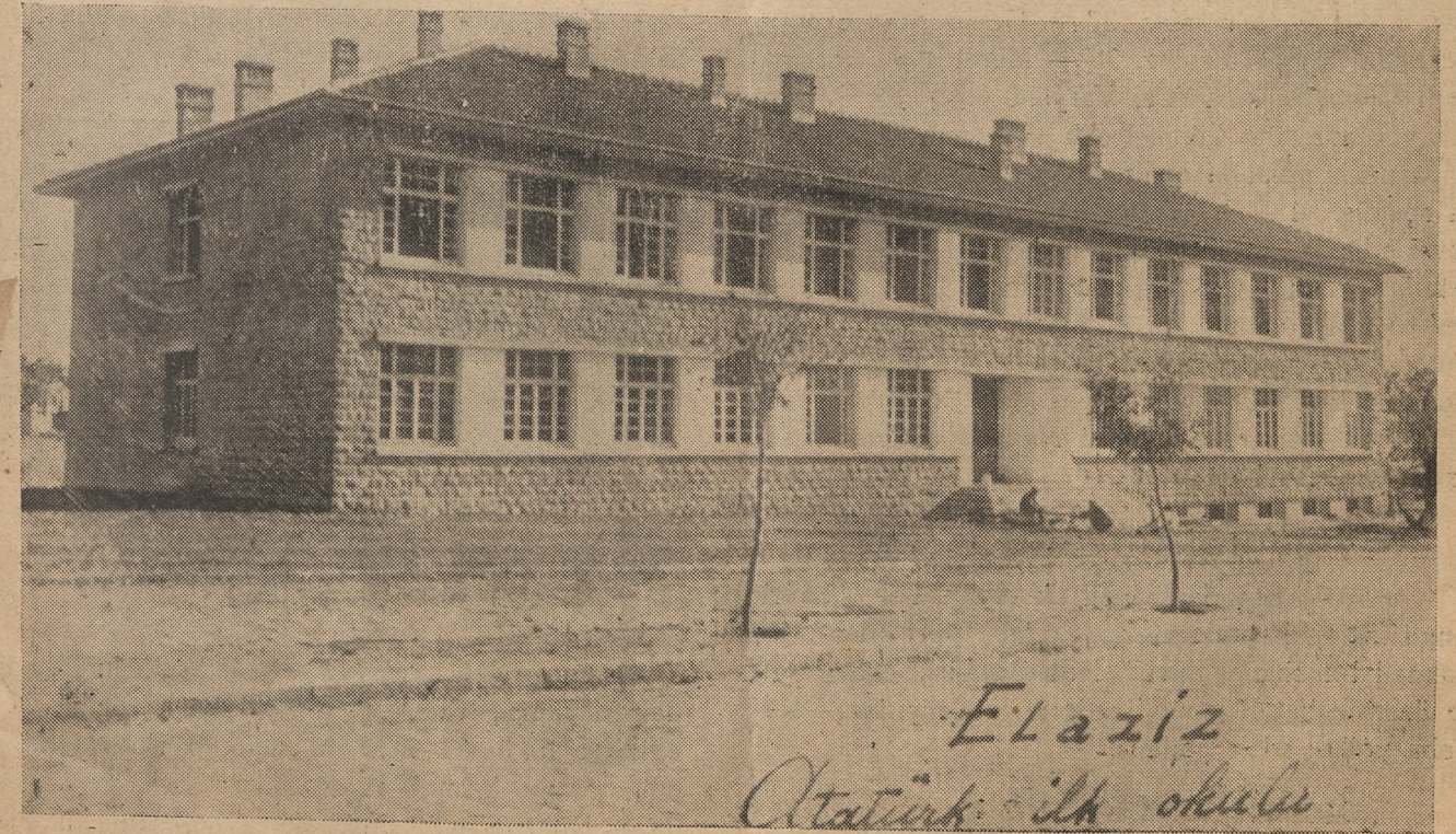
On dershaneli ve modern tesisatı haiz yeni yapılan Atatürk ilk okulu
