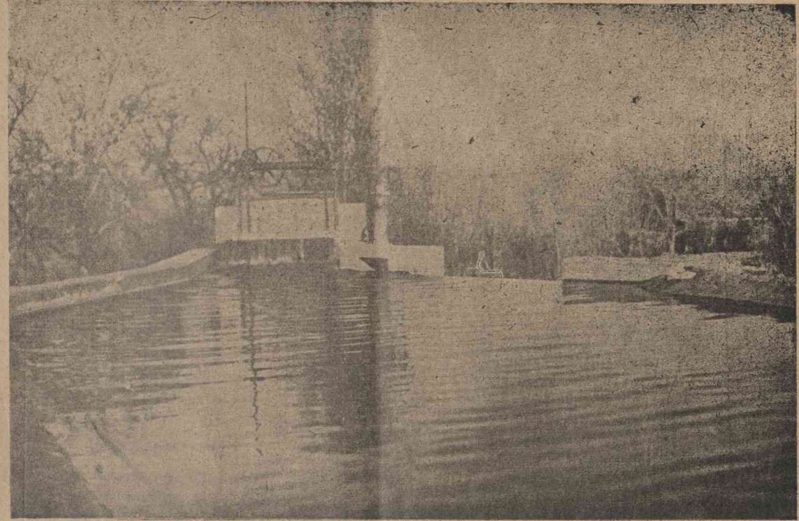
Bünyan Elektrik Havuzu
