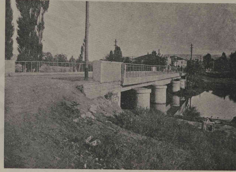
1936 da ikmal edilen akarbaşı köprüsü
