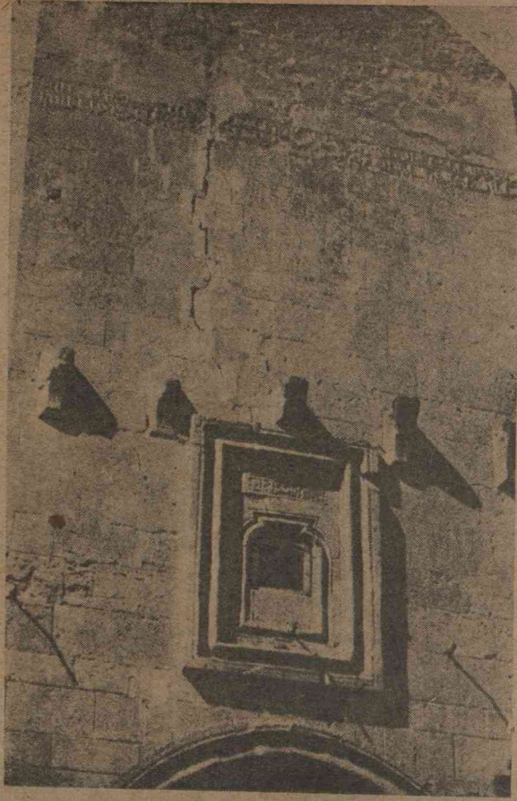
Selçukî sultanlarının türbesi
