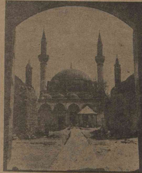
Karapınardaki Selimiye camii
